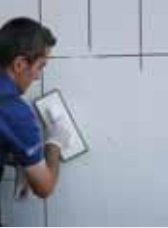
Dolgu malzemesinin duvara uygulanması
