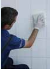
Nemli sünger ile derz yüzeyinin düzeltilmesi
