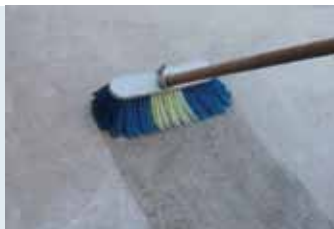
Yüzeyin temizlenip nemlendirilmesi
