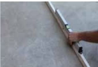
Yüzeyin düzgünlüğünün kontrol edilmesi
