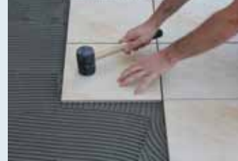
Çekiçle vurulup seviyelendirilmesi
