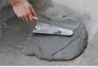
Harcın mala yardımı ile yüzeye aktarılması
